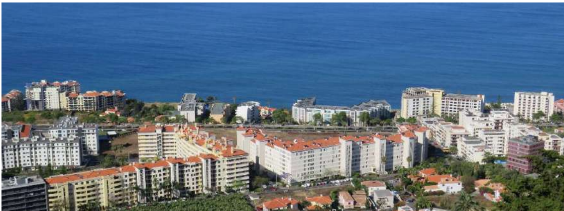
Fig. n.º 6 – Enquadramento da UE07 – vista geral.
