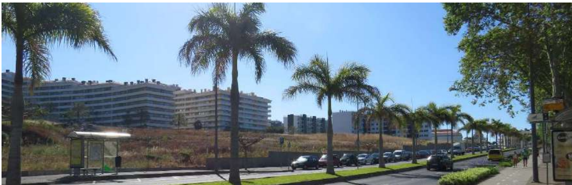
Fig. n.º 8 - Vista geral da Unidade de Execução 07 do Plano de Urbanização do Amparo.
